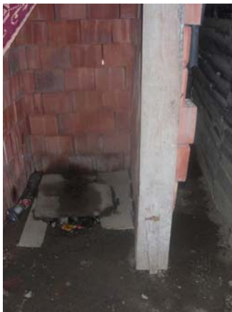
Die Toilette vor dem Haus von Agron Kryezi in Gjakova
